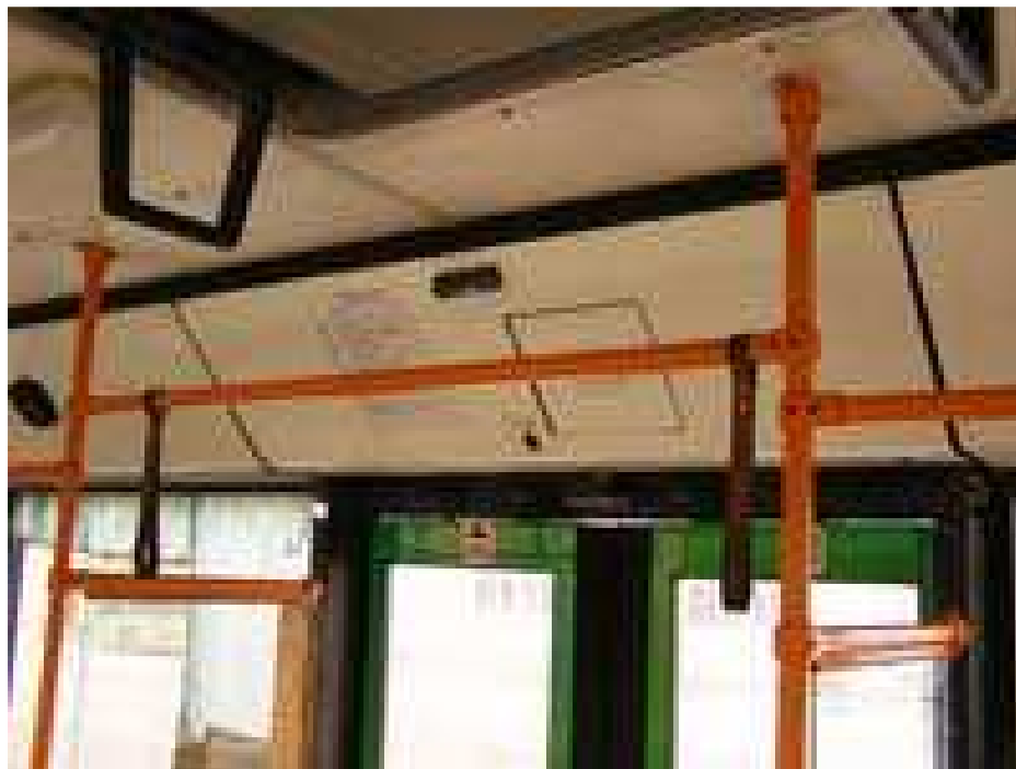
Рис. 4. Установка видеокамер контроля дверей
