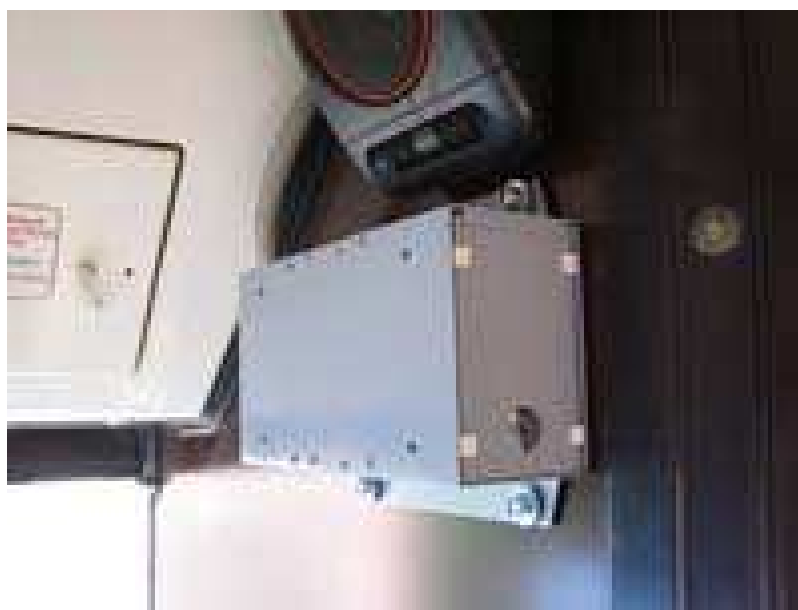
Рис. 6. Видеорегистратор, установленный в антивандальный сейф
