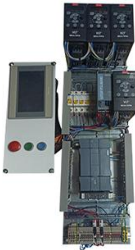
Рис.1 - пример монтажа электронных элементов управления
